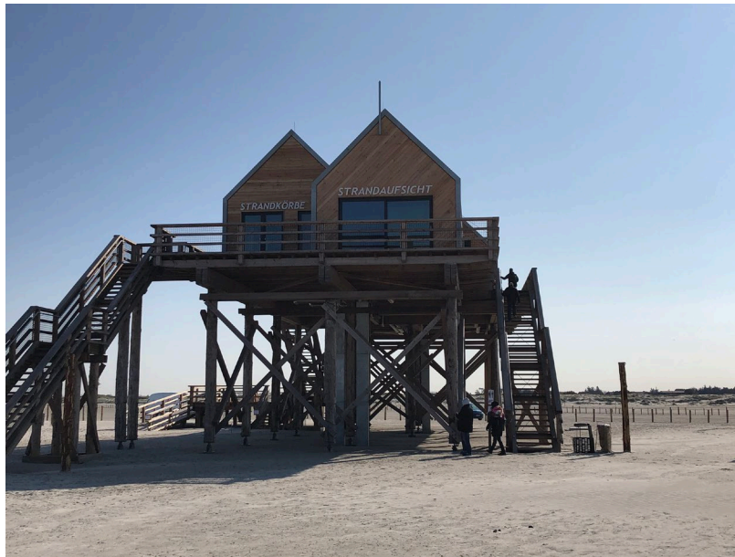
Der neue Mehrzweck-Pfahlbau in St. Peter-Ording wird ein neues Wahrzeichen des beliebten Touristenortes. ©TZ-SPO
